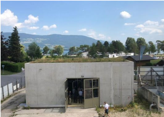
Abbildung 10: Gebäude, in dem die Wärme aus dem Auslauf der ARA Yverdon-les-Bains ans Wärmenetz geliefert wird.
