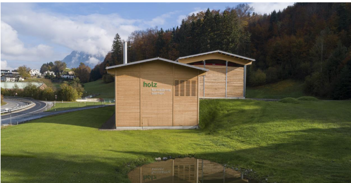
Abbildung 19: Heizzentrale und Brennstofflager WV Sarnen (Quelle: WV Sarnen).
