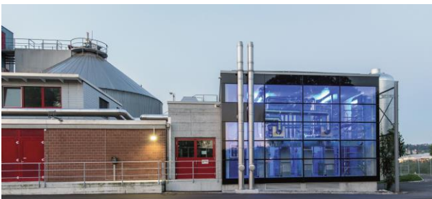
Abbildung 8: Energiezentrale des AV Morgental (Schweiz). (Bild: AV Morgental)
