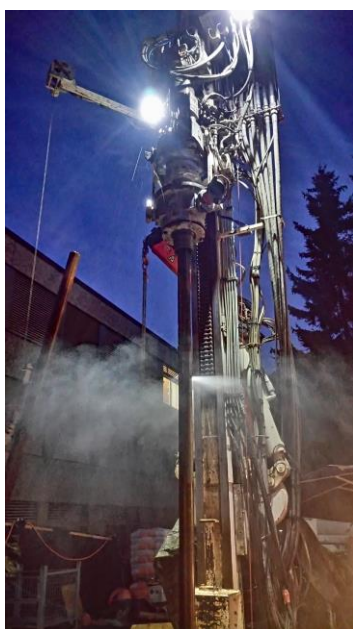
Illustration 14: Forage pour le réseau thermique. (Image : EWD AG)
